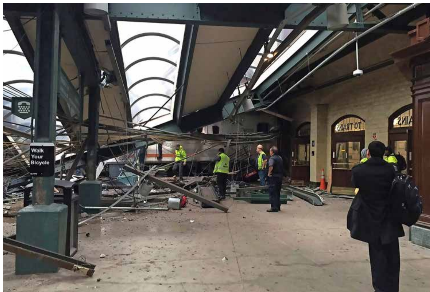
Le train a foncé sur les butoirs de la gare en cul-de-sac d'Hoboken, provoquant d'énormes dégâts. Keystone
